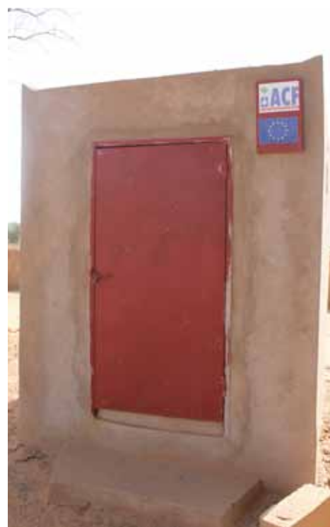
Photo 6 : Lieu de stockage pour déchets médicaux d'un centre santé ne disposant pas d'incinérateur
